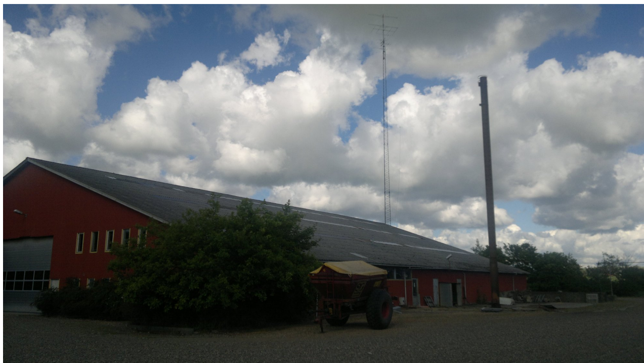
Kjeldbjergvej 19A. Maskinsation med nuværende mast og høj skortsten.
